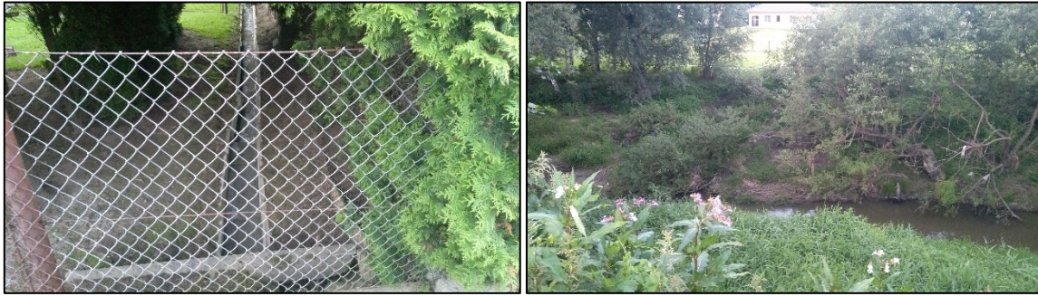
Rysunek 12 Rów przebiegający przez projektowany przepust P5. Widok odcinka górnego i ujścia do rzeki Strug.
