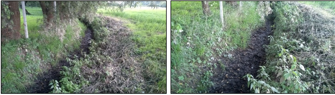
Rysunek 11 Rów w rejonie projektowanego przepustu P1
